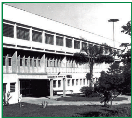
Fachada da FMJ em 1977.
