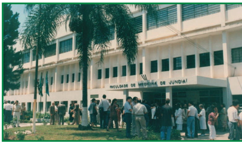
Fachada da FMJ em 1980.
