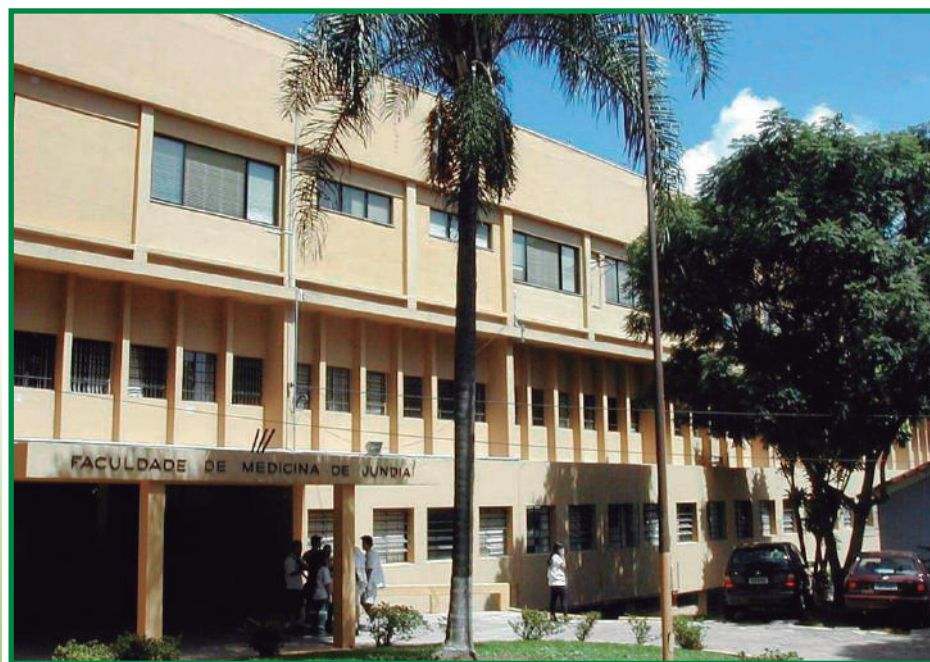
Fachada da FMJ com nova pintura – 1999.
