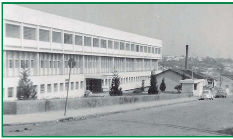
Fachada da FMJ em 1968.
